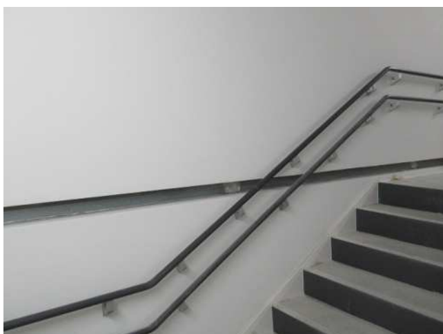
【免震層部分階段室】
