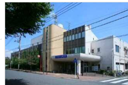
大師支所(地区健康福祉ステーション)
