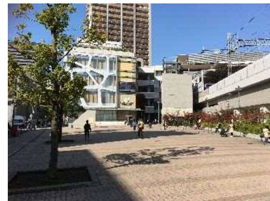
こすぎコアパーク (H26.4供用開始) ※現在リニューアル工事中
