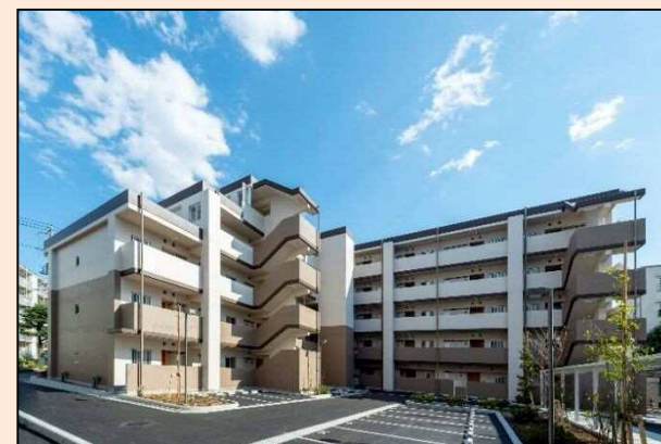
<完成後の写真>
