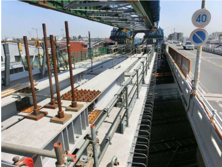
世田谷町田線（登戸） 橋梁新設工事中
