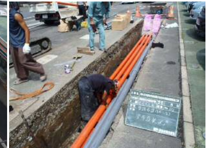
世田谷町田線（片平） 道路拡幅・無電柱化工事中
