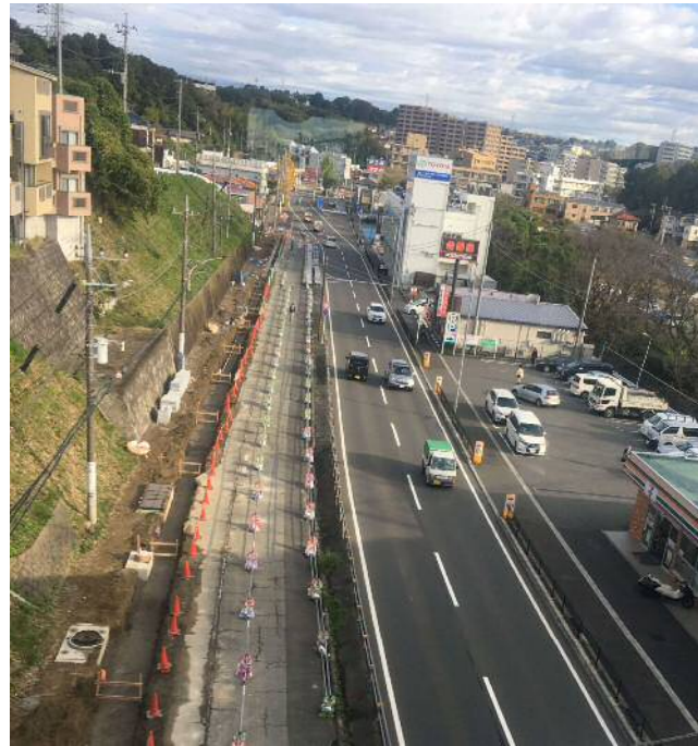
世田谷町田線（片平） 道路拡幅・無電柱化工事中
