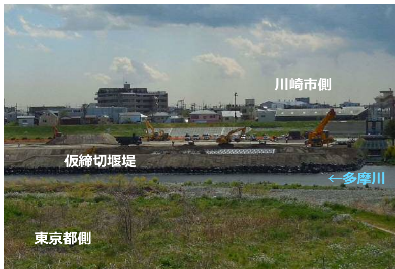
(市道) 宮内新横浜線 (仮称) 等々力大橋 護岸工事中
