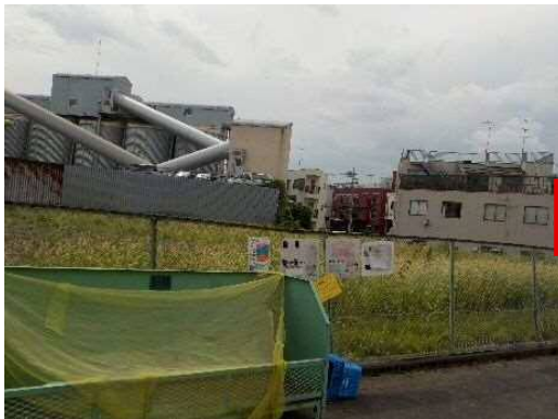
宮内新横浜線(宮内)の道路予定地
