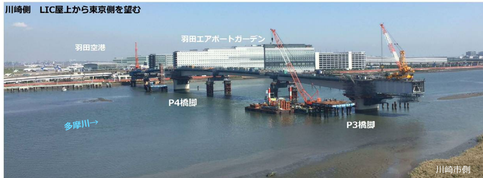
(仮称) 連絡道路 (仮称) 羽田連絡道路 新橋建設工事中
