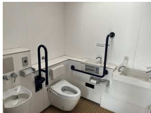
トイレ内部（特定公園施設）
