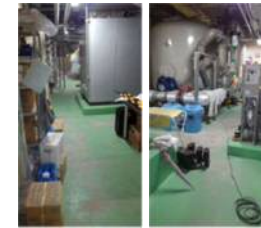
【設備機械室A・ろ過機室防塵塗装】
