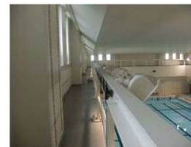
【プール2階メンテナンス通路】
