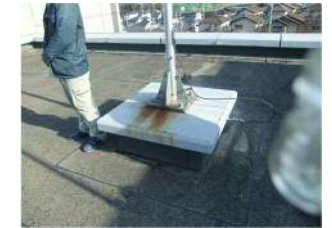
【屋上避雷針架台補修】
