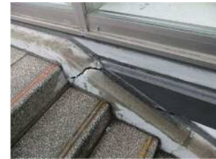
【屋外階段基礎取り合いシール打ち換え】
