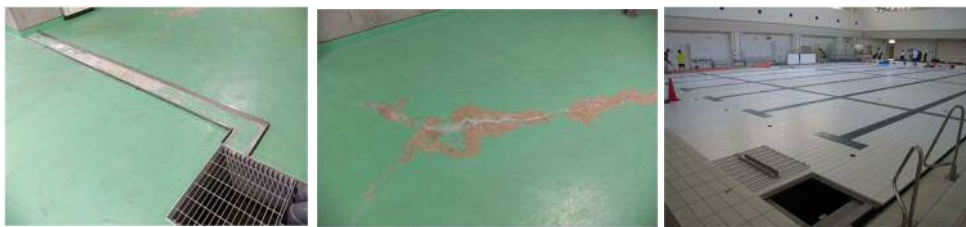
【地下漏水修繕箇所】
