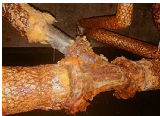
老朽化した配管
