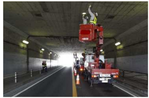
道路施設点検の状況
