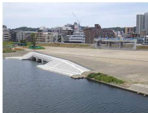
五反田川放水路の整備状況（多摩川への放流部）
