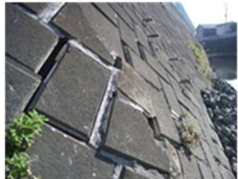
護岸変化の状況
