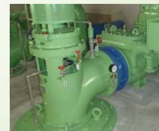
設備(ポンプ等)の更新
