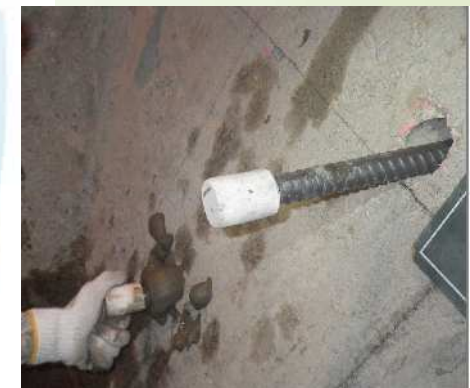
汚水揚水機能の地震対策 (せん断補強筋の施工など)
