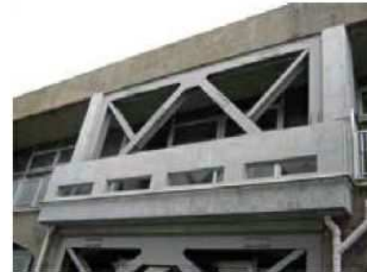
管理機能の地震対策 (ブレースの設置など)
