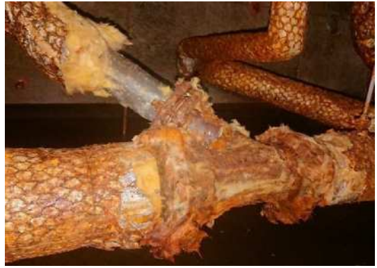
老朽化した配管
