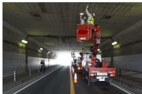
道路施設点検の状況
