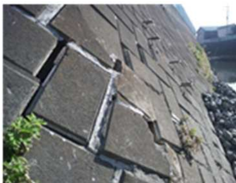
護岸変化の状況
