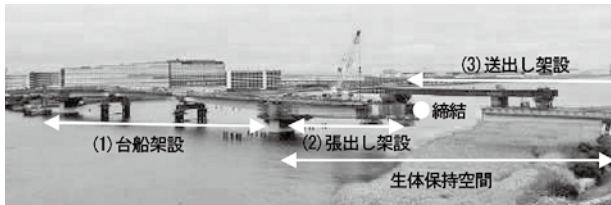
上部工架設状況(令和3(2021)年1月)
