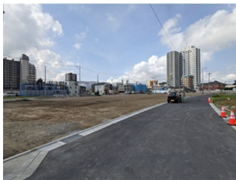
区画整理事業が進む登戸駅付近 令和 3（2021）年 6 月
