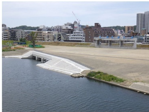
五反田川放水路の整備状況（多摩川への放流部）
