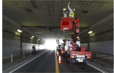
道路施設点検の状況
