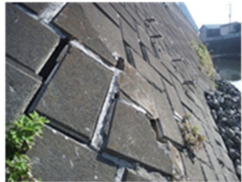
護岸変化の状況
