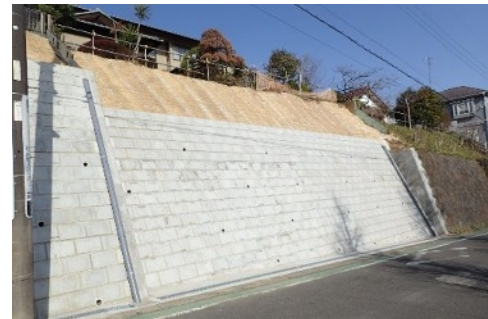
宅地防災工事助成制度を活用した擁壁の改修例
