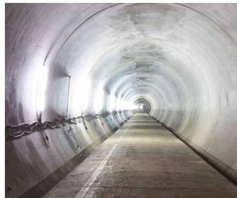
大師河原貯留管
