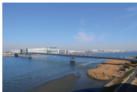
多摩川スカイブリッジ
