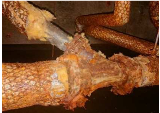
老朽化した配管
