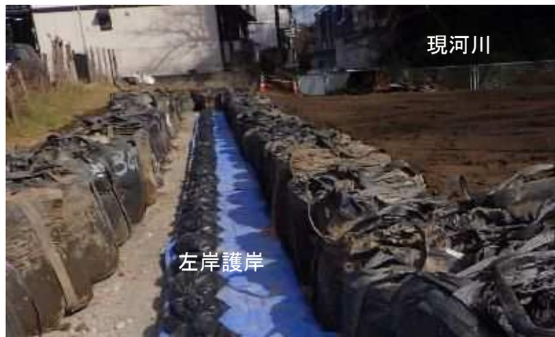
左岸護岸の築造後に、右岸護岸の築造を行うため埋戻しを実施
