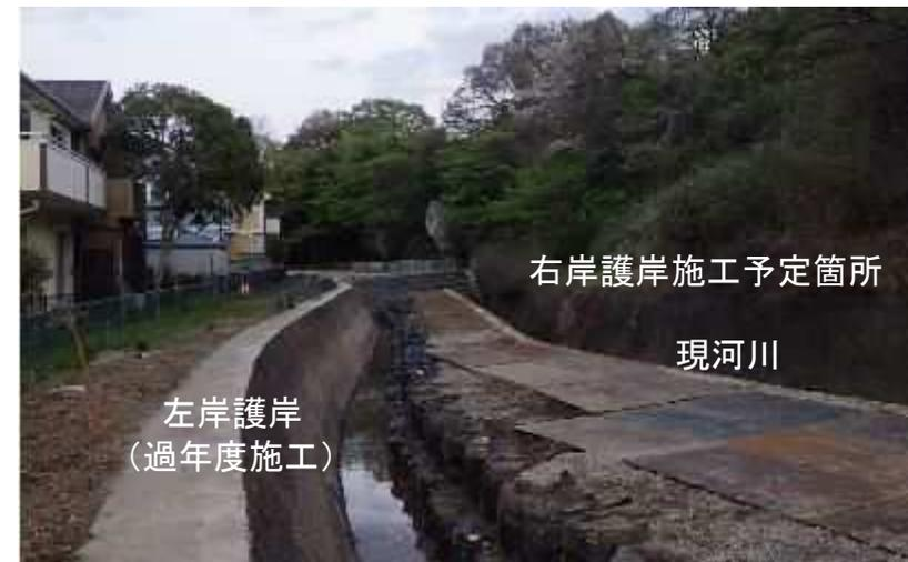
右岸護岸築造のため水の流れの切り替えを実施
