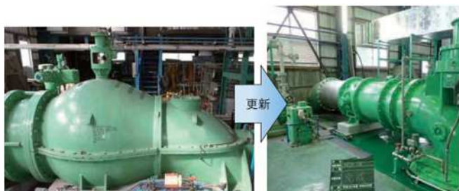
老朽化したポンプ設備の更新
