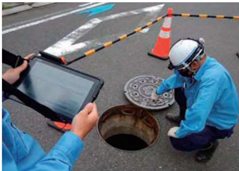
アセットマネジメント情報システムによる維持管理情報の蓄積 (左: 管きよの点検状況 右: 設備の点検状況)
