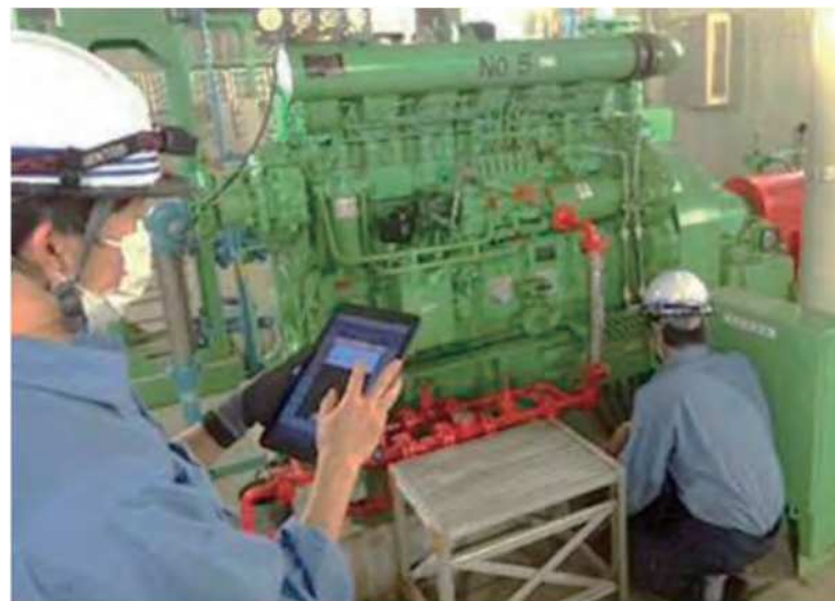
アセットマネジメント情報システムによる維持管理情報の蓄積 (左: 管きよの点検状況 右: 設備の点検状況)
