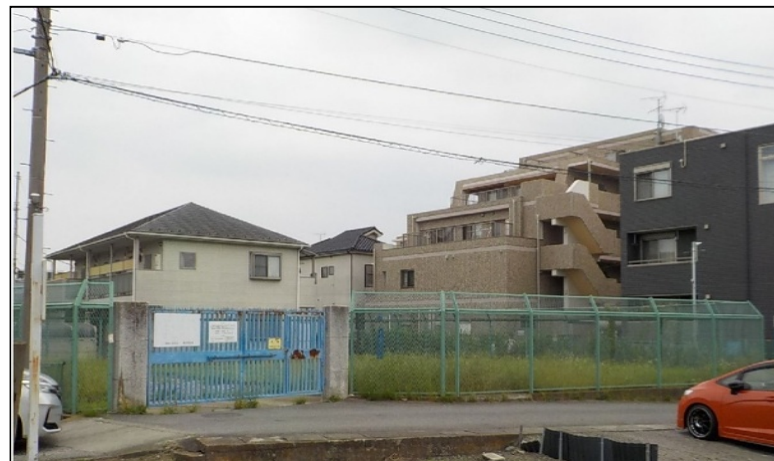
④北西側 (全景)
