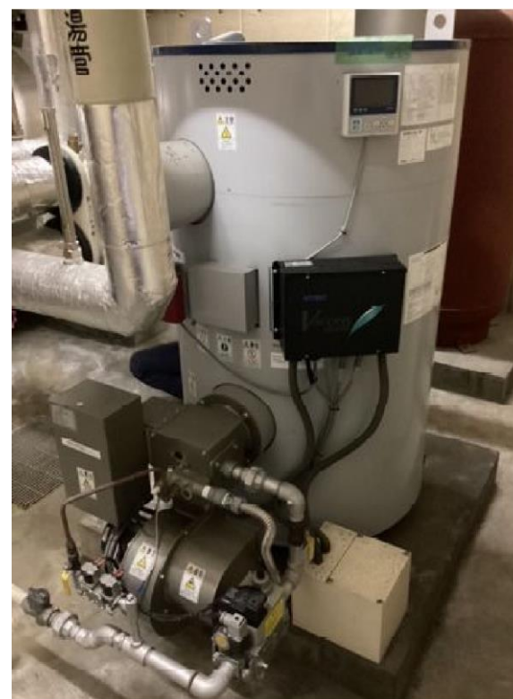
機械設備(給湯ボイラー)
