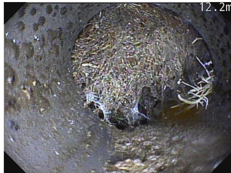
排水管(100A) 2F~5F系統 柵合流部
