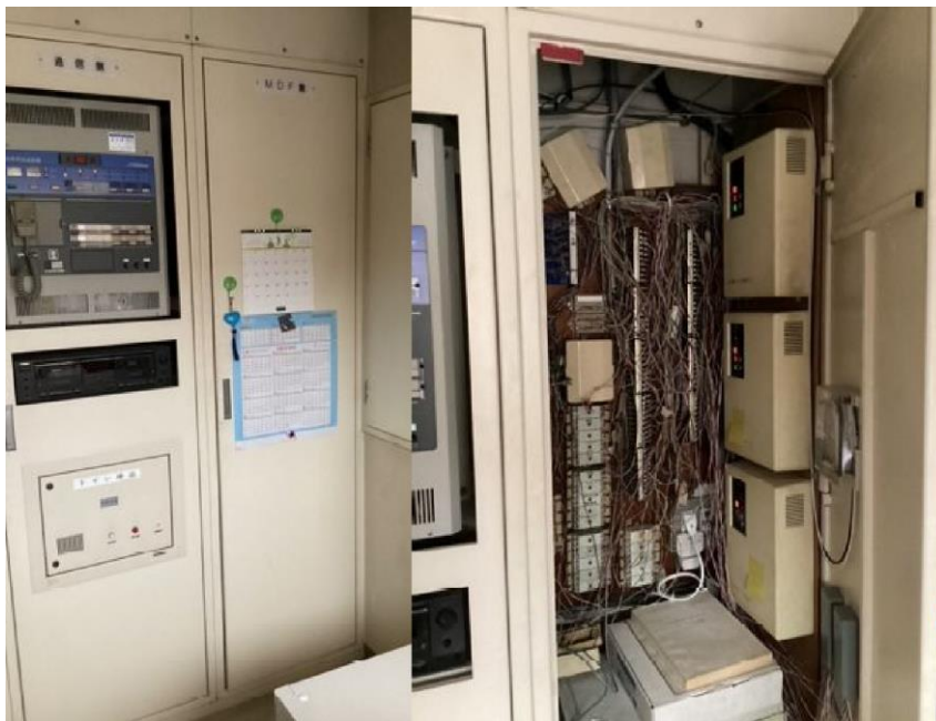
電気設備(監理室 MDF盤)
