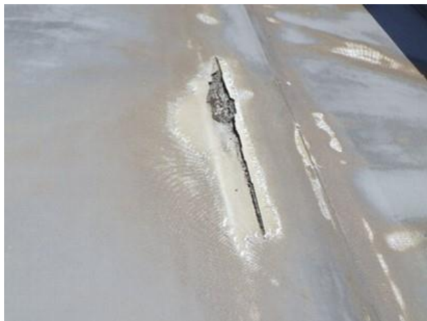
屋上屋根 防水層
