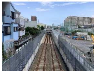
浸水防止壁設置工
