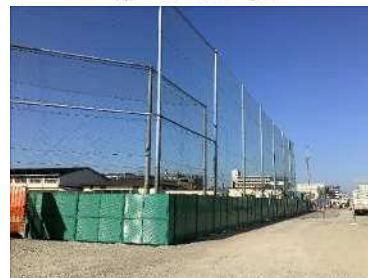
工事ヤード復旧工
