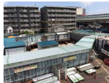
構内通路設置工（大師橋駅）
