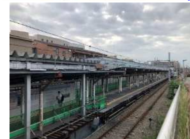
上家架設工（小島新田駅）
