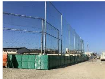
工事ヤード復旧工
