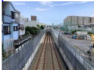
浸水防止壁設置工
