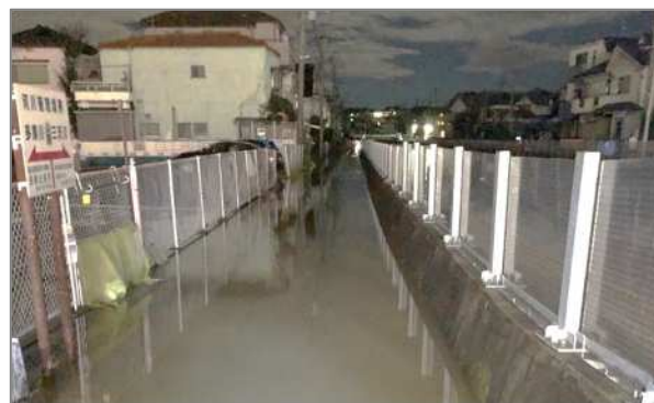
現場状況（三沢川管理用通路）
