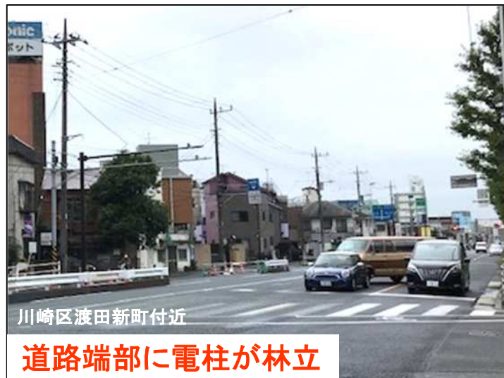
「老朽化・地震対策」A01-014((市)南幸町渡田線)
