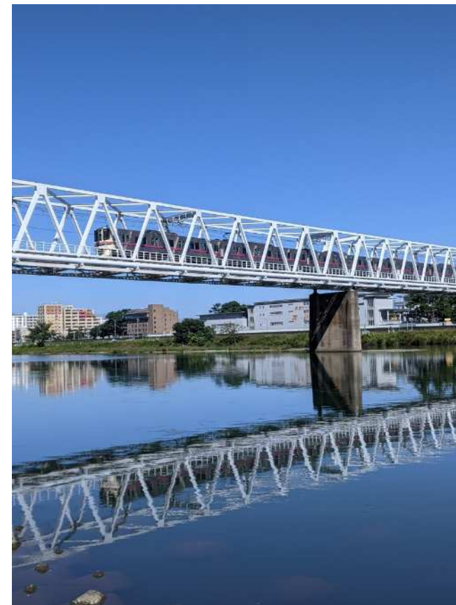
撮影場所：京王線多摩川橋梁 被写体名：多摩川を渡る京王線電車 撮影者様：阿部 雅之 様
