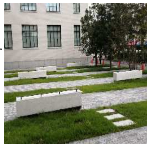
本庁舎アトリウム（半屋外）
