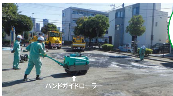
ハンドガイドローラーという道具を使って地面をならしています
