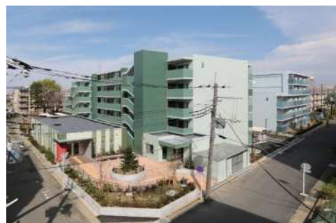
新5号棟、集会所 (H27年度竣工)
