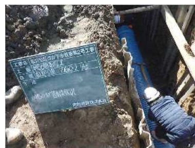
人孔・管路設置（下水道）
