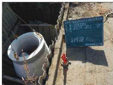
人孔・管路設置（下水道）
