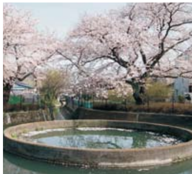
久地円筒分水 (高津区) Kuji Ento Bunsui (Takatsu Ward)
