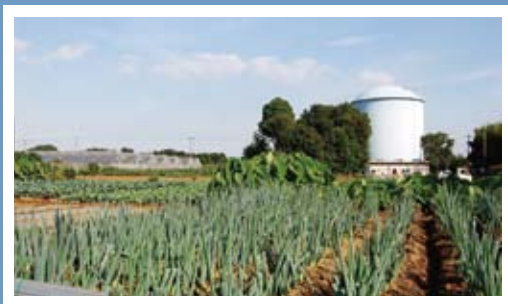
都市農業が盛んな久末地区のシンボル「配水塔」
