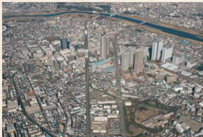
再開発が進む武蔵小杉駅周辺
