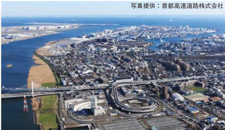
川崎縦貫道路「大師ジャンクション」 Kawasaki Longitudinal Road, "Daishi Junction"
