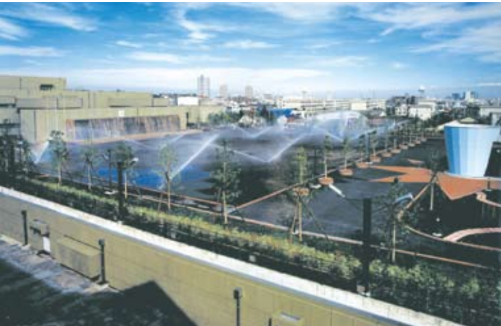
災害時の一時避難場所として整備した「加瀬水処理センター」 The "Kase Wastewater Treatment Center", a temporary refuge facility in the event of disasters
