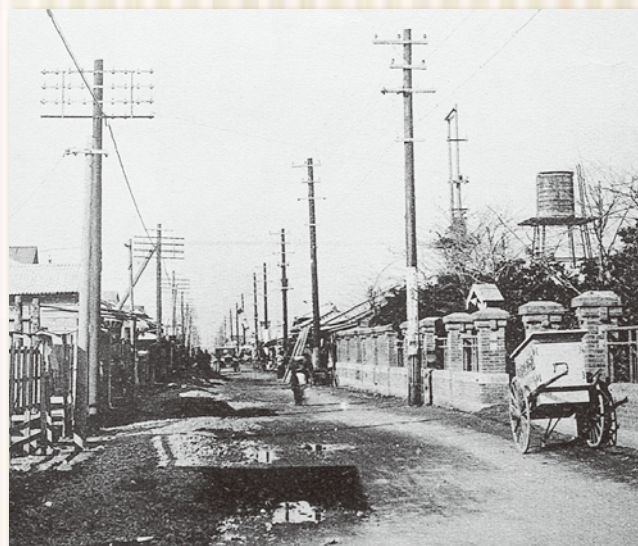
※6 昭和2年、鋼管通り
