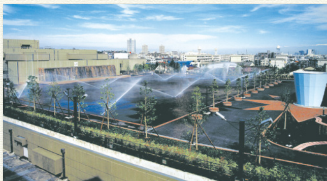
災害時の一時避難場所として整備した「加瀬水処理センター」 The "Kase Wastewater Treatment Center", a temporary refuge facility in the event of disasters
