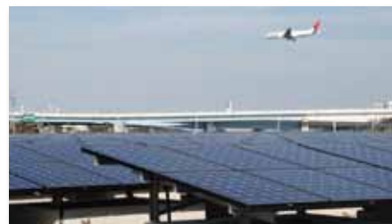
川崎大規模太陽光発電所 Kawasaki Mega Solar Power Generation Plant
