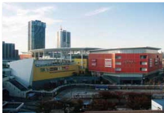
常に多くの人でにぎわう大型商業施設「ラゾーナ川崎プラザ」 “LAZONA Kawasaki Plaza”, a large commercial shopping complex bustling with people
