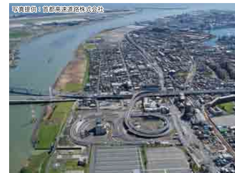
川崎縦貫道路「大師ジャンクション」 "Daishi Junction" of the Kawasaki Longitudinal Road
