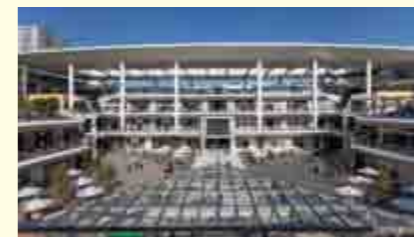
常に多くの人でにぎわう大型商業施設「ラゾーナ川崎プラザ」 "LAZONA Kawasaki Plaza", a large commercial shopping complex bustling with people
