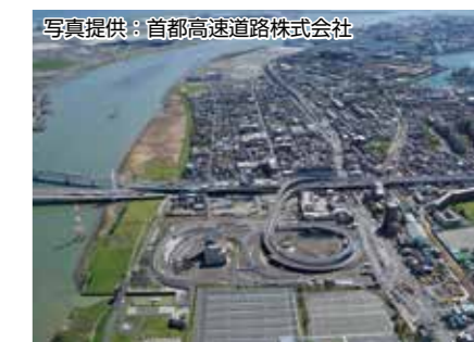
川崎縦貫道路 「大師ジャンクション」 "Daishi Junction" of the Kawasaki Longitudinal Road
