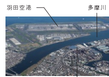
羽田空港 多摩川 キングスカイフロント 羽田空港まで車で10分とアクセス抜群
