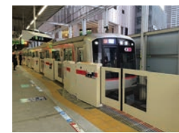
東急東横線武蔵小杉駅ホームドア
