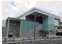
J・R南武線津田山駅橋上駅舎化
