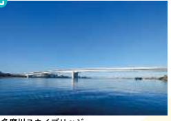
多摩川スカイブリッジ
