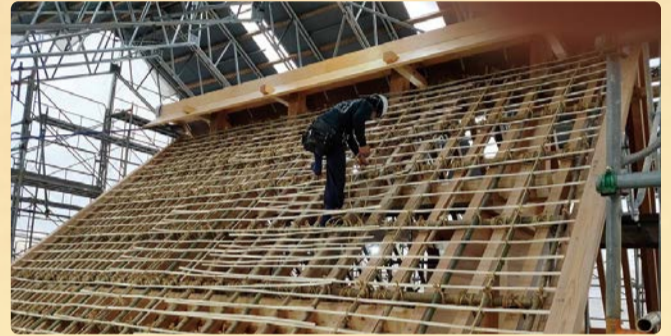
屋根の茅葺き作業の様子
