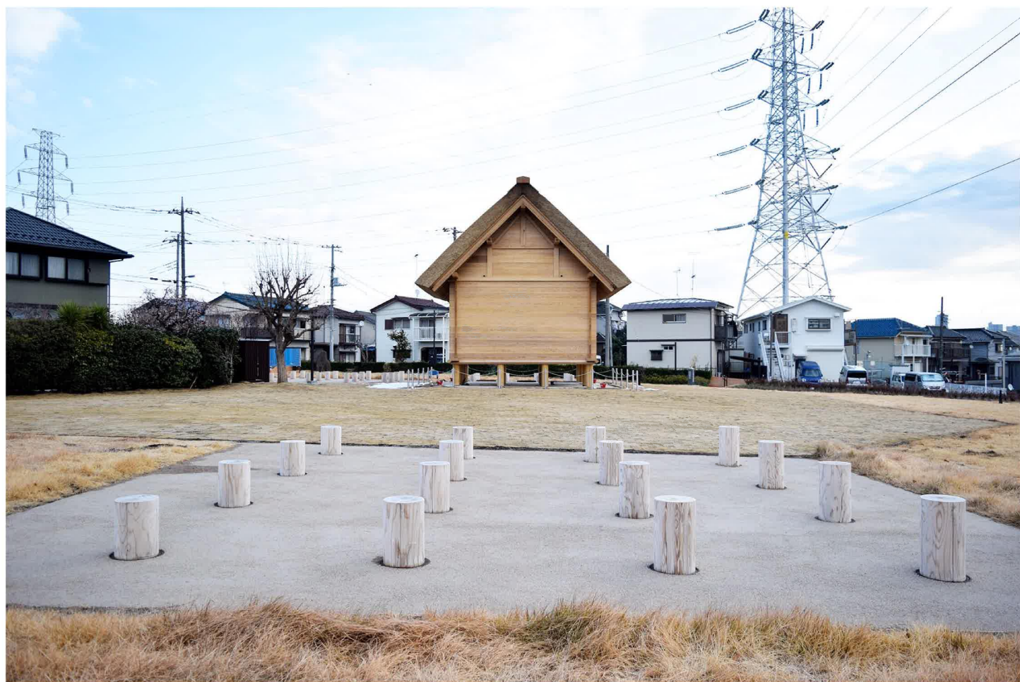
③ 柱の一部復元と復元倉庫（南西から）
