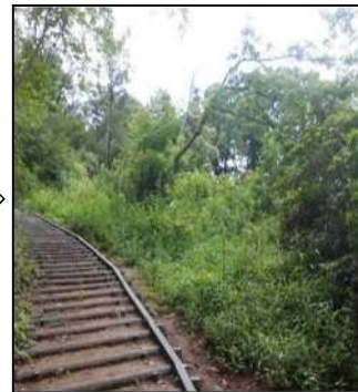
園路整備施工後
