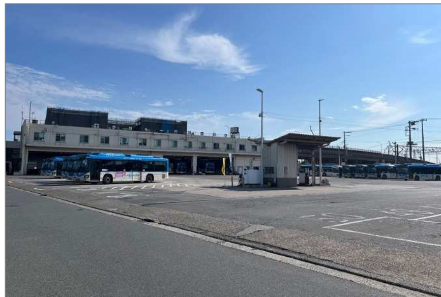
東側敷地(事務所、整備工場、車庫など)
