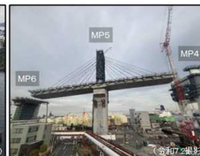
③主橋梁部MP4～MP6
