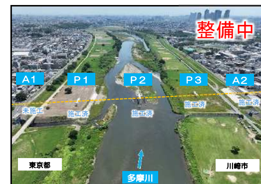
A01-005(市)宮内新横浜線((仮称)等々力大橋) ※A1は橋台設置予定箇所(未施工)、その他の橋脚・橋台は施工済み
