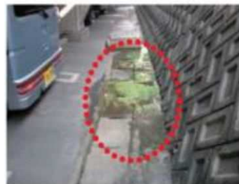
湧水部分にコケが生えている擁壁
