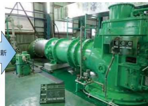
老朽化したポンプ設備の更新
