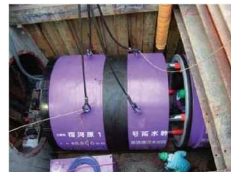
雨水管の整備（推進工法）
