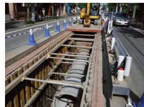
雨水管の整備（開削工法）
