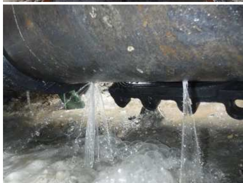
劣化により破損した汚泥圧送管
