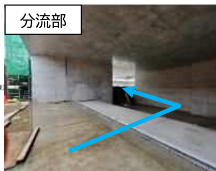
※五反田川の水位が 上がると堰が転倒し、 放水路内に取水
