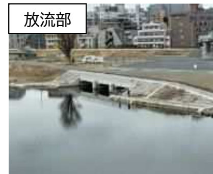
堤外水路 ※放水路内の河川水を多摩川へ排水
