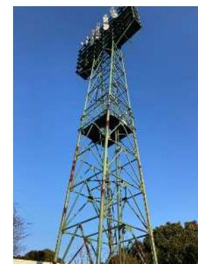
全体的に腐食し、破断・亀裂が見られる照明塔を更新
